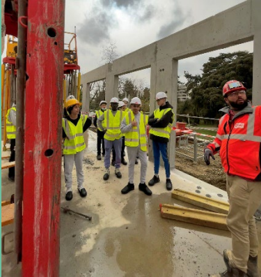
Visite d'un chantier de l'entreprise de BTP, ETPO
